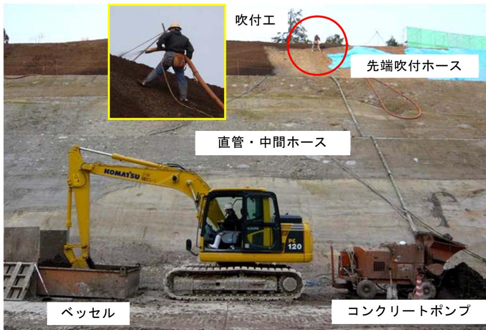
写真 3-11 生育基盤材の搬送・吹付
