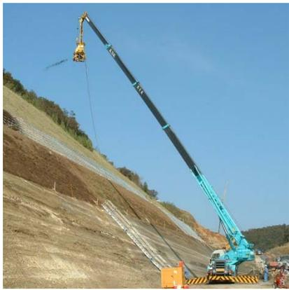
写真 2-3 クレーン方式高所施工
