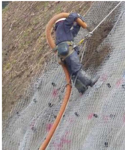
写真 3-14 先端吹付ホースによる生育基盤材の吹付
