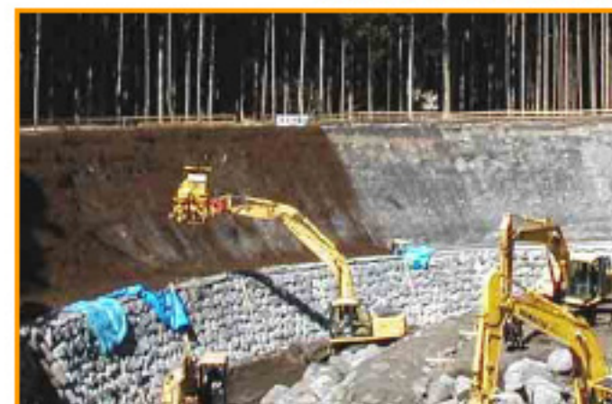
ネッコチップ工法の施工
